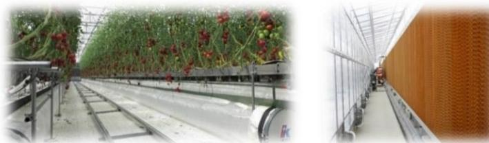
クールパッドを利用し空調室で整えた冷気をファン/ダクトを介しガター下に送り込みます。平地での夏越しトマト栽培が可能です。空調室では暖気、炭酸ガス等も調整します。
